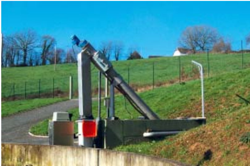
Photos 5 et 6 – Tamis statique à alimentation directe.
