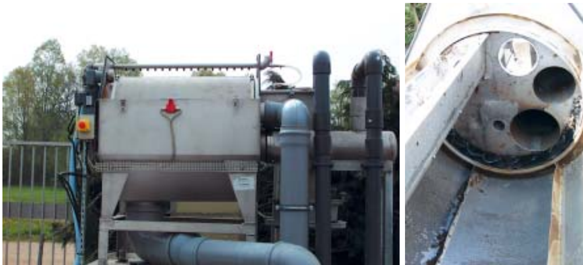
Photos 3 et 4 – Tamis rotatif à alimentation interne.
