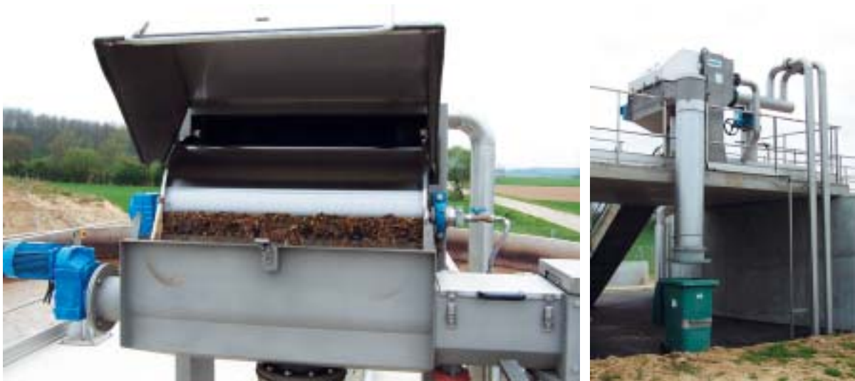
Photos 1 et 2 – Tamis rotatif à alimentation externe.
