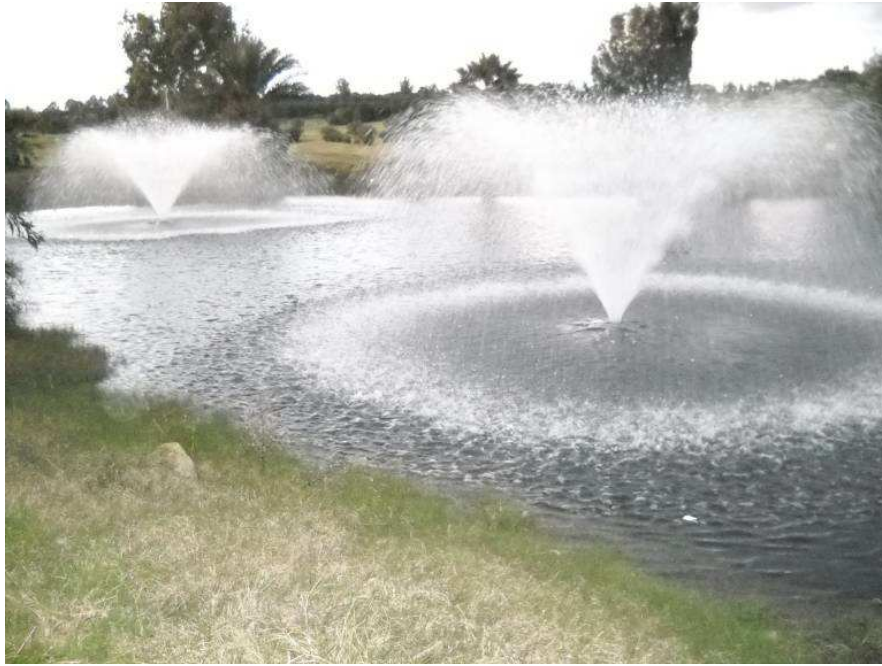
Figure 25 : Aération des lagunes de stockage du golf de Citrus et Yasmine dans l'arrière-pays d'Hammamet, Tunisie (rapport AFD)
