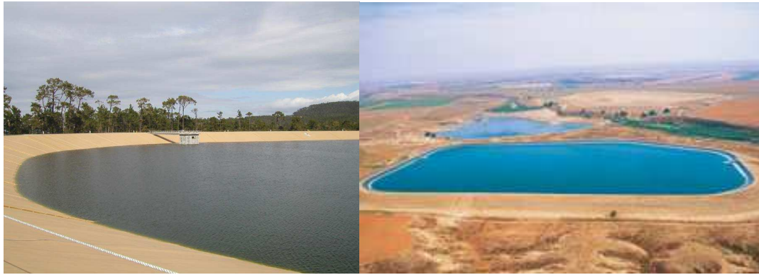
Figure 18 : Réservoirs saisonniers à surface libre A gauche : Réservoir de stockage de surface des EUT de Forest Lake en Californie, Etats-Unis ( http://www.pbcasd.org ) A droite : Réservoir de stockage de surface des EUT en Israël ( http://www.jnf.org )
