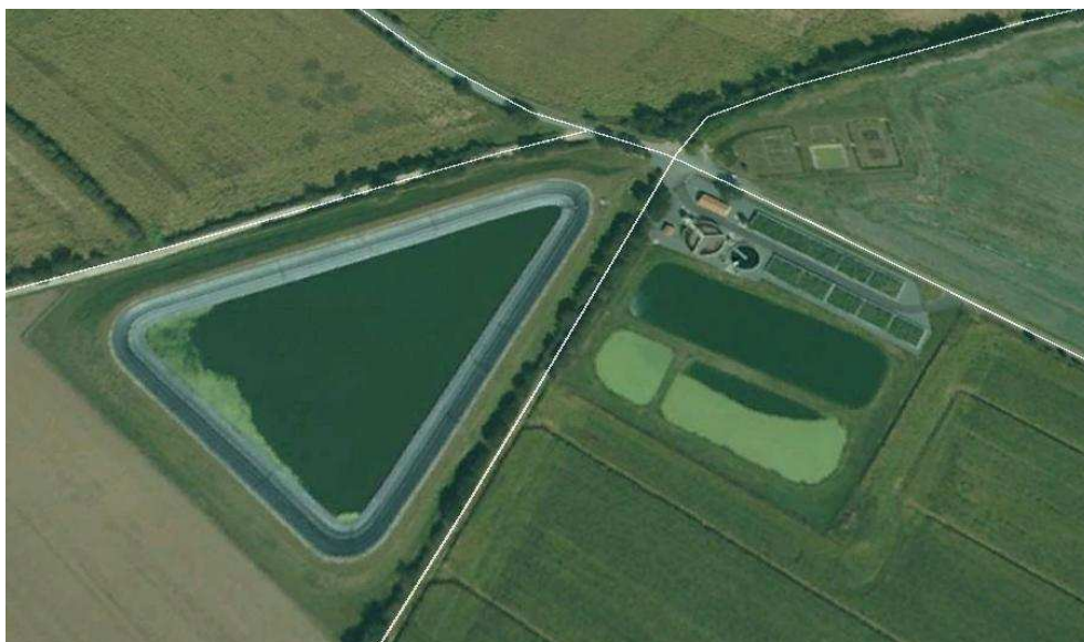
Figure 15 : Image satellite de la station et réservoir de stockage associé de Thorigné (79) (extrait Google Earth)
