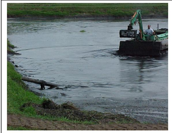
A gauche, les engins utilisés et la vidange totale des bassins à curer permettent d'assurer une opération aussi complète que possible. Un tel chantier nécessite une organisation des transferts d'effluents dans l'une ou l'autre des lagunes pour assurer la continuité du traitement .
