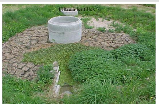
Photos du haut et de gauche : filtre à lentilles installé en sortie d'un troisième bassin de lagunage. Lorsque les accumulations sont importantes, il est nécessaire de les évacuer hors du filtre.
