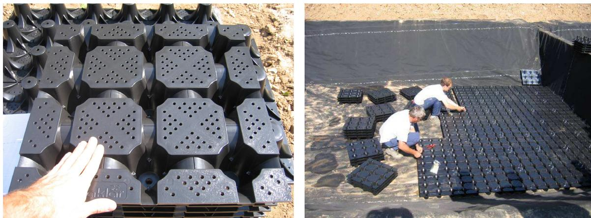
**Figure 3 : photos du plancher aérant Biobloc®**
