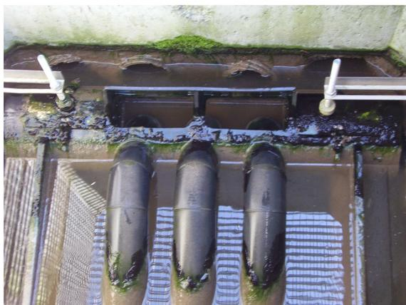
Figure 4 : Photo des drains saturés
