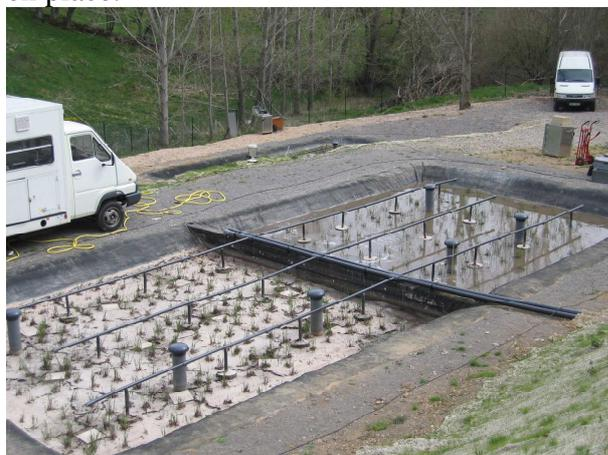
Figure 1 : Ramps d'alimentation du premier étage de traitement. Burdignes le 24/04/2006
