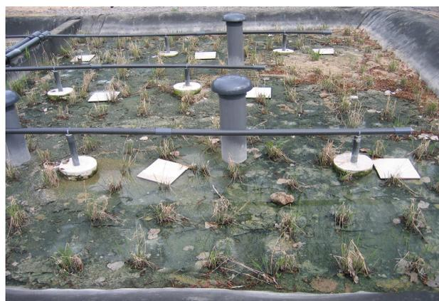
Figure 2 : ramps d'alimentation du deuxième étage de traitement. Burdignes le 24/04/2006
