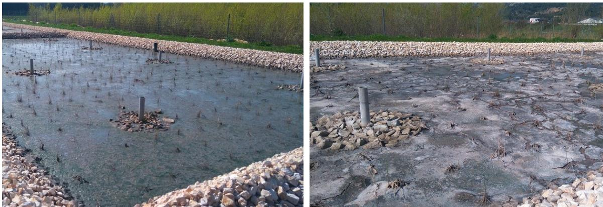
Figure 1. Flaquage prolongé sur un filtre en alimentation (à gauche) et dépôt de boues séchées sur le filtre au repos depuis plus de 7 jours (à droite), sur le 1<sup>er</sup> étage d'une station jeune démarrée en hiver et recevant une très forte charge organique.
