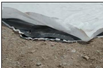
Géomembrane et géotextile
