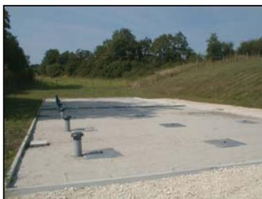
Le 2<sup>e</sup> étage est composé d'un bassin, séparé en 2 unités fonctionnelles, elles mêmes divisées en 2 sous unités alimentées alternativement par un jeu de vannes. Les sous unités peuvent être utilisées lorsque les charges entrantes sont faibles, sur un réseau neuf avec peu de branchements.
