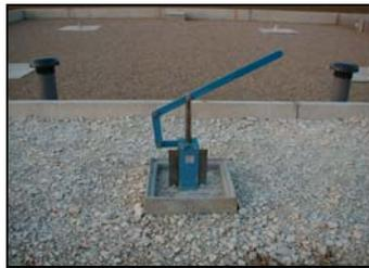
Les vannes guillotines sont moins étanches et nécessitent un nettoyage régulier (grippage du levier).
