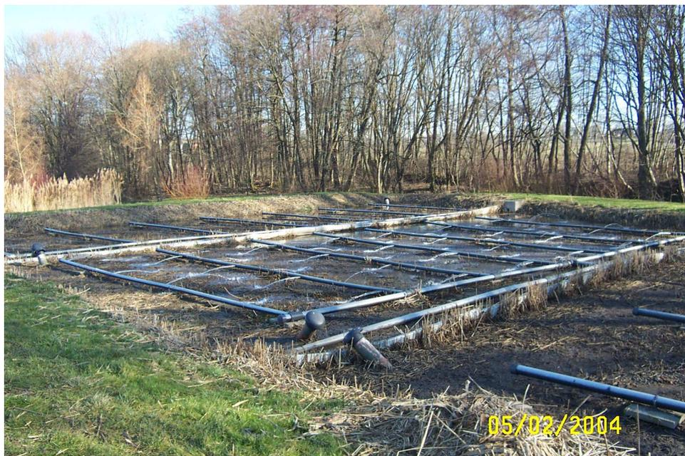
Figures 5 : Vue d'un réseau superficiel de tuyaux percés d'orifices.
