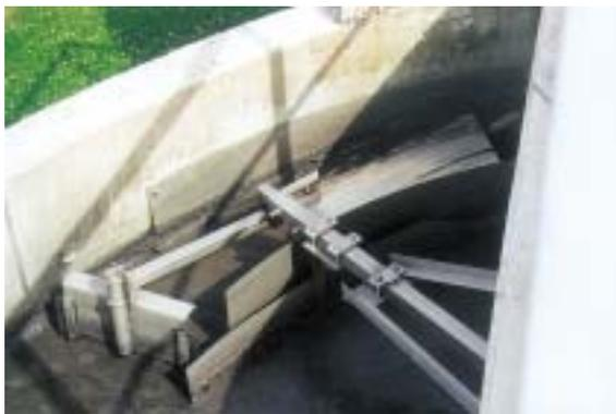
Figure 21 – Système de raclage d'un dégazeur
