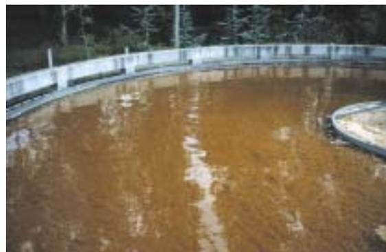
Figure 14– Voile de boue haut dans le clarificateur
