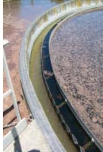
Figure 9 – Flottants de dénitrification en surface du clarificateur
