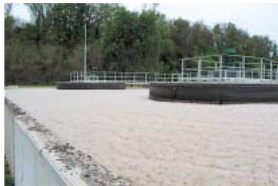
Figure 6 – Mousse biologique en surface de bassin d'aération
