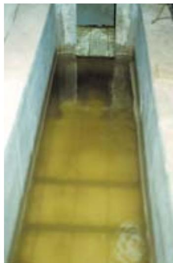
Figure 16 – Sortie station – rejet « chargé » suite à des pertes de MES du clarificateur
