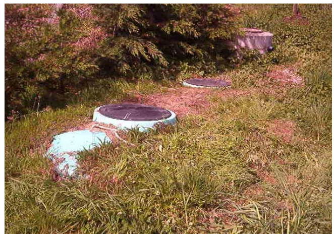
Fosse Septique Toutes Eaux Sur un filtre à sable
