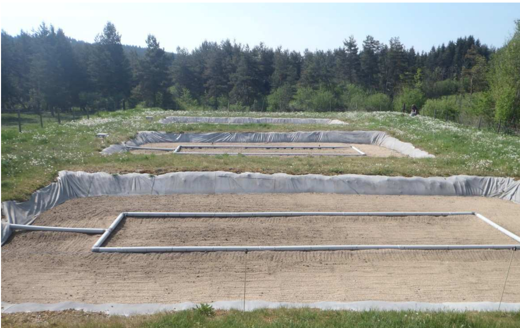
Figure 2 – Bassins d'Infiltration Percolation de Merle-Leignec (42) (photo: Cemagref)
