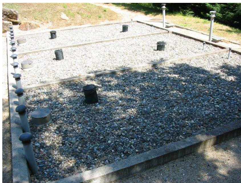
Figure 6 – Filtre à Zéolite de Campouriez (Aveyron) (photo: SATESE 12)
