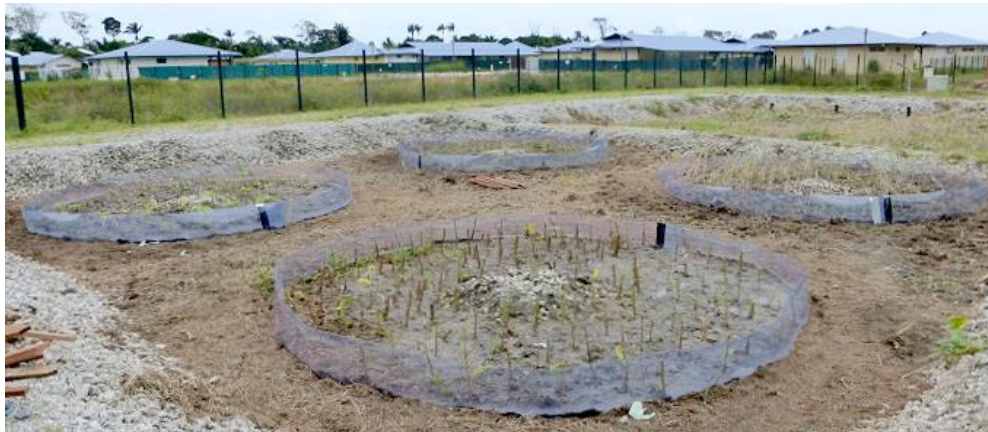
Figure 12 : Réduction de la surface en service autour de chacun des points d'alimentation de bois d'Opale 2. Photo Etiage.
