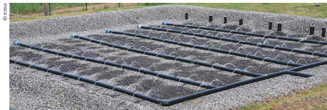
Figure 8. Alimentation sur le 2 e étage de la station de Mansarde Rancée (Martinique) avant plantation, février 2014.
