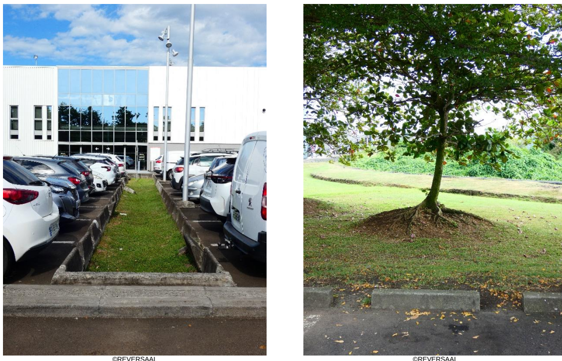
Figure 15 : photographies de dispositifs de gestion des eaux pluviales implantés sur le site du Carrefour Génipa (Martinique).
