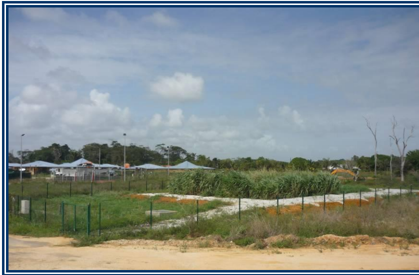
Figure 7 : Station de Bois d'Opale 1, vue générale en janvier 2013
