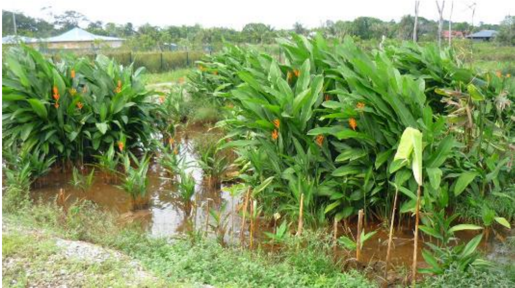
Figure 8 : filtre 1 de la station de Bois d'Opale 1, Heliconia psittacorum , flaquage conséquent suggérant un colmatage partiel du filtre.
