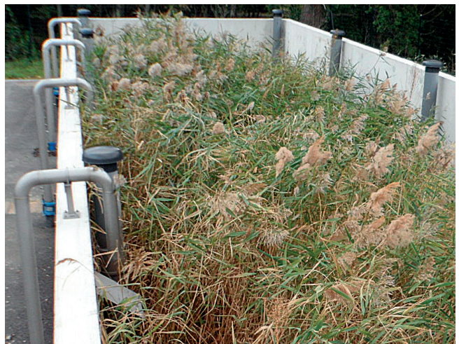
Canalisation d'alimentation inox, plaque déflectrice et cheminée d'aération munie d'un chapeau
