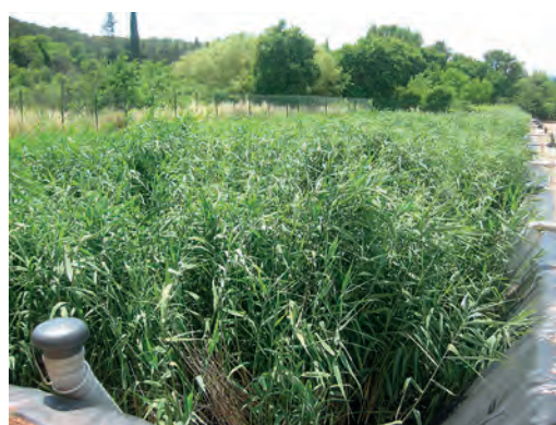
Densité de roseaux suffisante pour appliquer une charge de fonctionnement nominale (de l'ordre de 250 tiges/m 2 )
