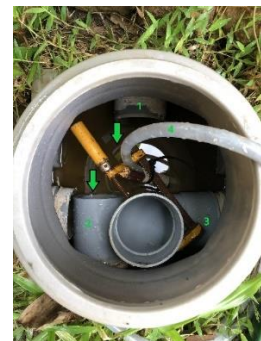
1 : Drain principal (Sortie des Eaux Traitées)
