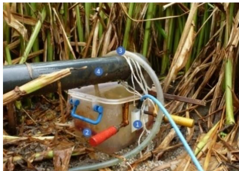
1 : Capteur de surverse fixé à l'extérieur du bac de prélèvement. Le capteur détecte le débordement du bac et déclenche un prélèvement. 2 : Bac de prélèvement de l'effluent 3 : Tuyau à crépine positionné dans le bac. 4 : Canalisations d'alimentation du filtre
