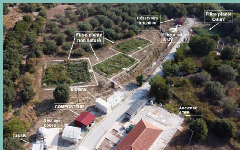
Implantation du système d'assainissement
