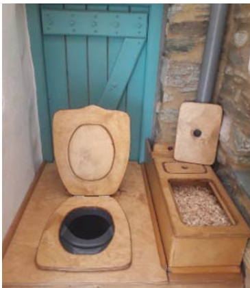
Toilettes sèches (photo Eric MINO, HYDROUSA ou SEMIDE, à préciser)
