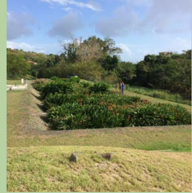
Etage de filtres plantés de végétaux en Martinique (crédit photo INRAE)
