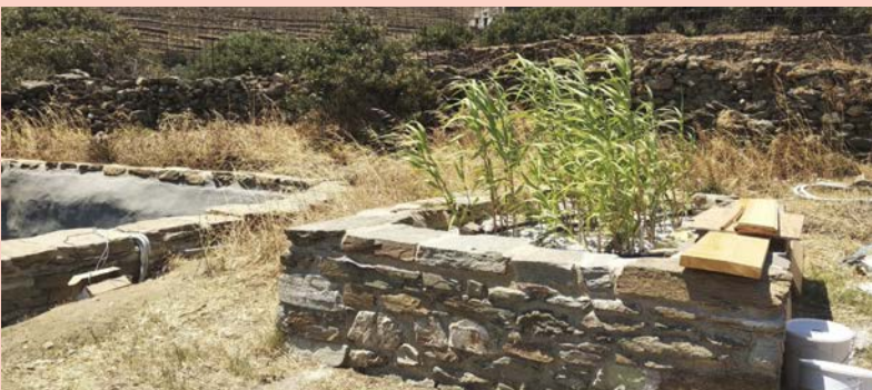
Filtre planté opérationnel
